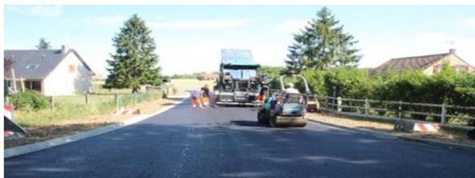
Au total sur l'ensemble des chantiers : 6 200 tonnes d'enrobés mis en place avec l'atelier de finisseur ont été réalisés ainsi que 1 160 tonnes à la niveleuse.
